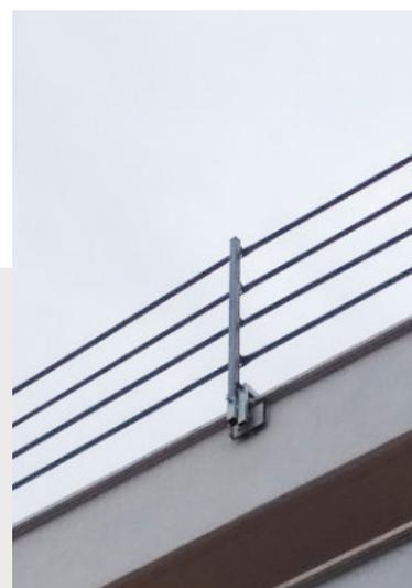
Il parapetto è stato realizzato e certificato per essere utilizzato come sostegno di protezione provvisoria contro la caduta dall'alto durante le attività di costruzione, riparazione o ristrutturazione, permettendo di lavorare sui balconi, terrazze, scale e tetti.
